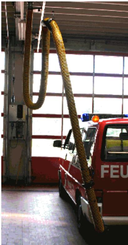
ABB. 9.4.1 Abgasabsauganlage - Soll
