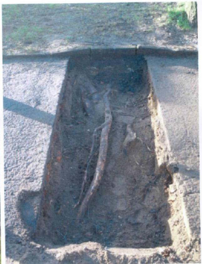
Wie auf Grund der Oberflächenbeschaffenheit des Gehweges und der räumlichen Nähe der Linden zum Gehweg zu vermuten, befinden sich zahlreiche und starke Wurzeln unmittelbar unterhalb des Asphaltbelages.
