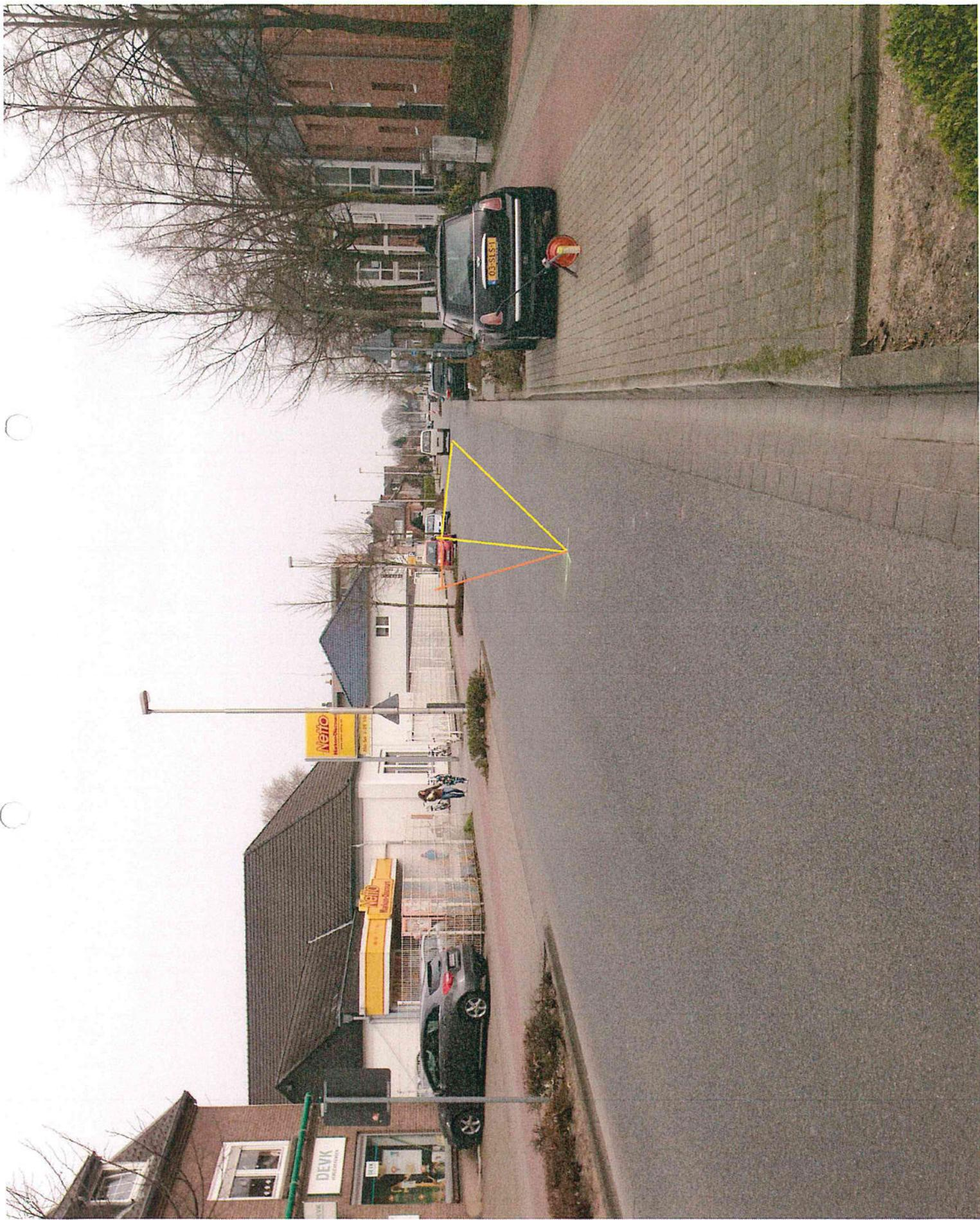
der Kraftfahrzeuge besser angepasst ist als der Kreisbogen. Ein Vorteil des einfachen Kreisbogens ist – neben gestalterischen Aspekten – die kürzere Tangentenlänge der Eckausrundung, was besonders bei einmündenden Anliegerstraßen und bei Gehwegüberfahrten (Kontrollradius) von Bedeutung ist.
