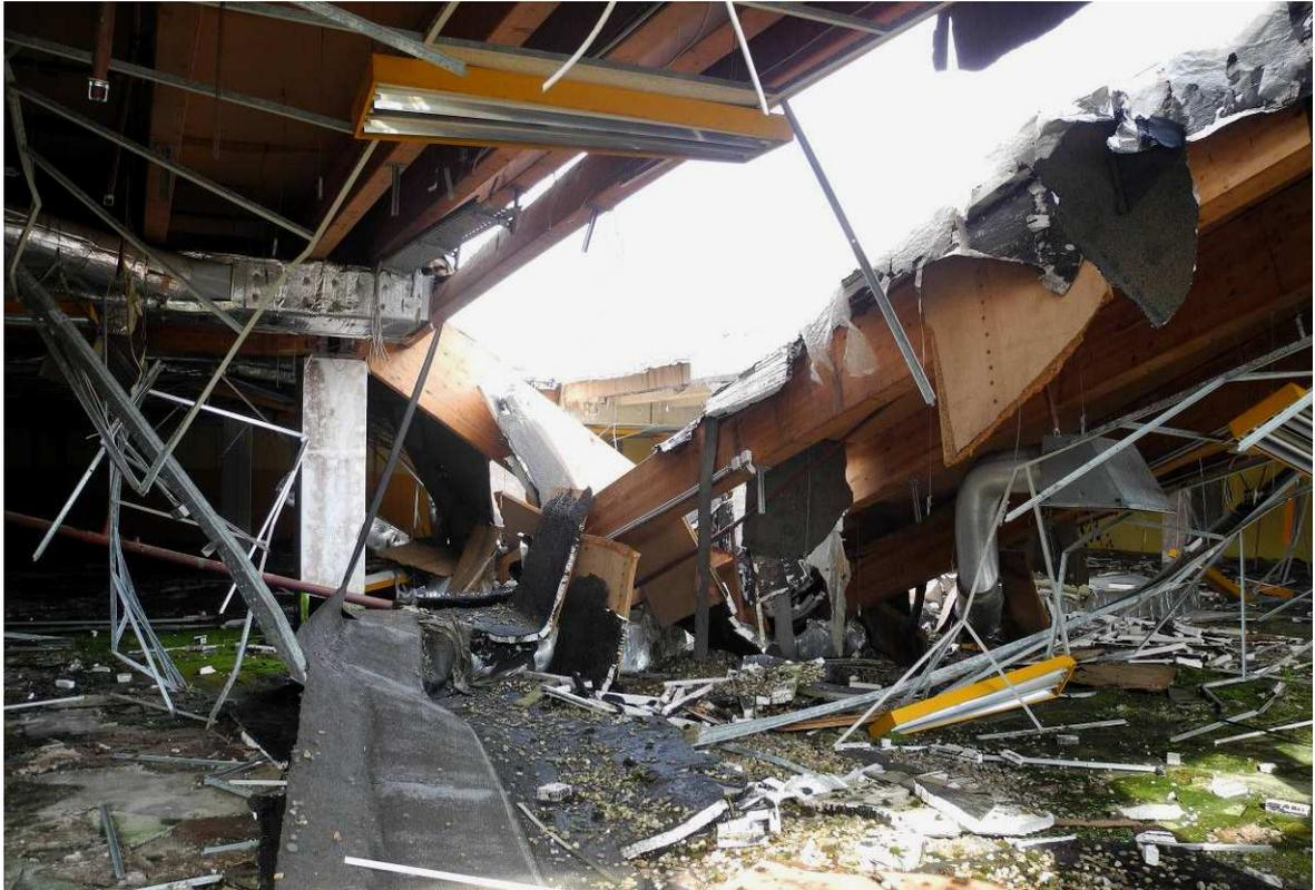
Abbildung 08: Eingestürzter Dachkonstruktion (Einsturz im Oktober/November 2013)
