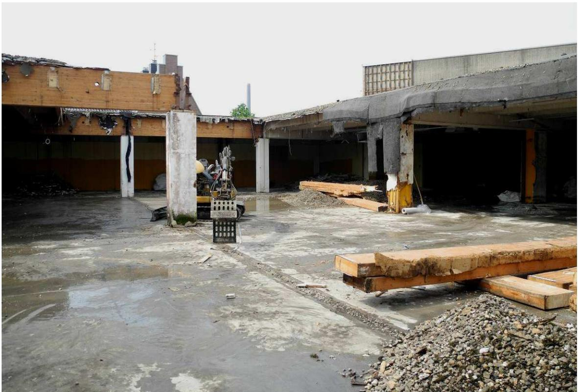
Abbildung 09: Eingestürzter Dachkonstruktion nach der Baufeldräumung (April 2014)
