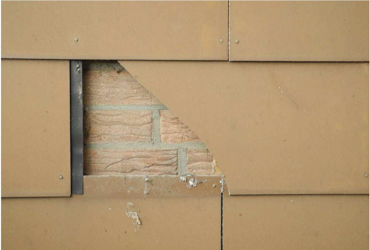
Abbildung 22: Potenzielle Einflugöffnung in Vorsatzfassade
