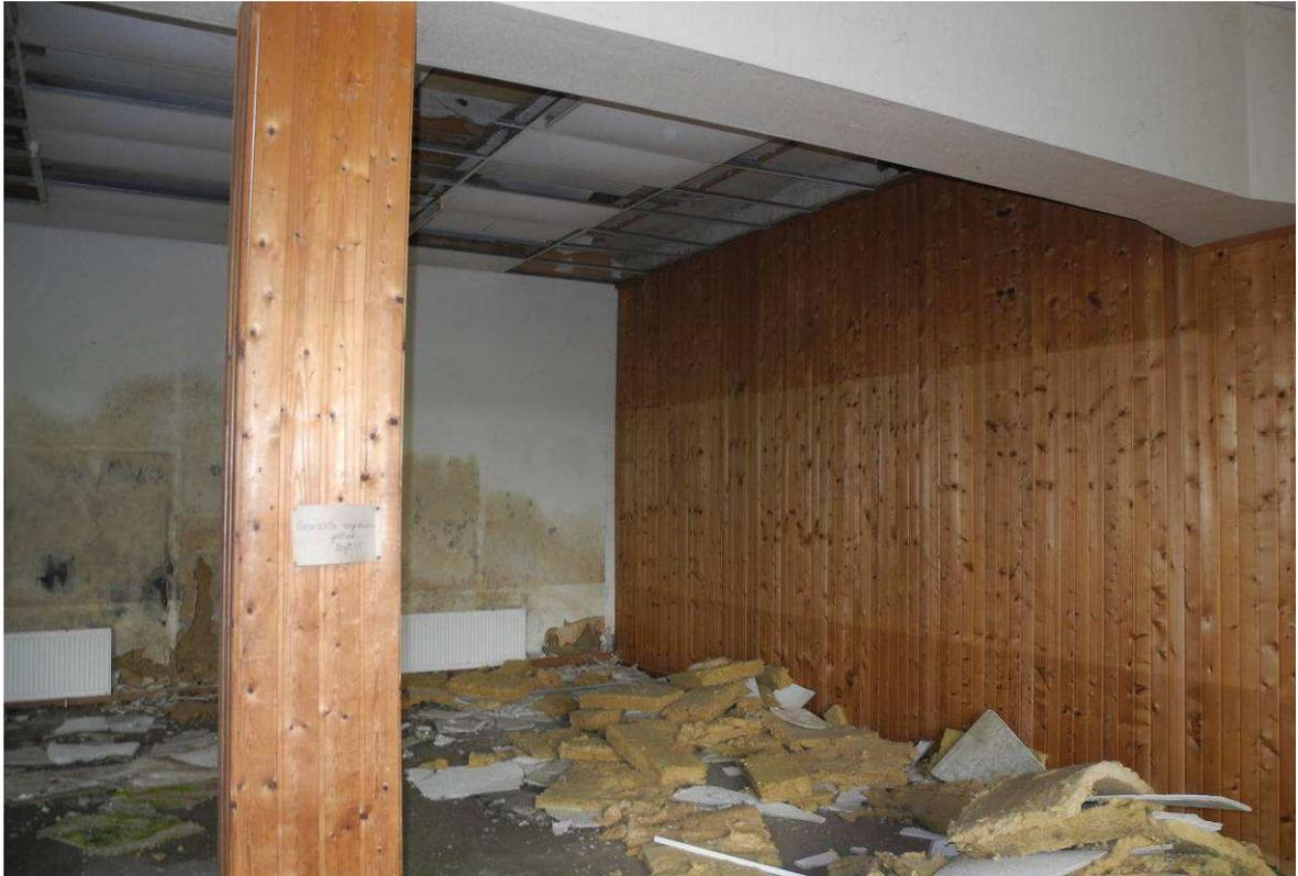
Abbildung 16: Ehemalige Geschäftsräume (OG) vor der Schadstoffsanierung (Mineralfaser-Dämmplatten)
