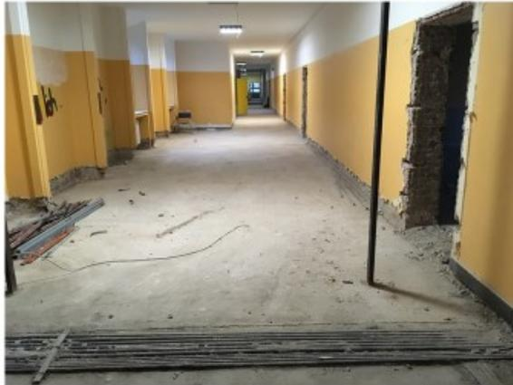
Aufgrund der Substanz musste der Estrich entfernt werden. Dies stellt einen zusätzlichen Aufwand dar, da der Estrich eigentlich im Gebäude verbleiben sollte.
