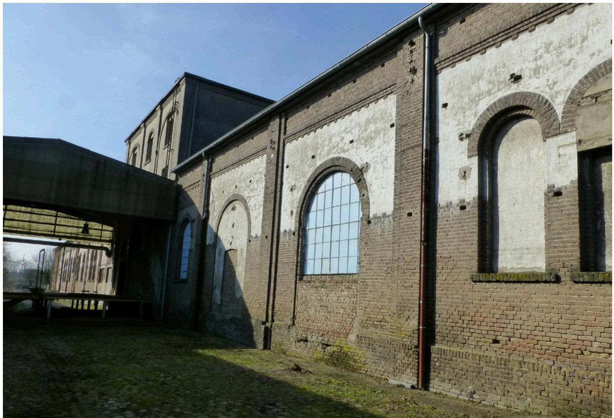
Abbildung 5: Die jüngeren Gebäude sind verputzt und teilweise mit Wellzementplatten verkleidet (oben). An den älteren Gebäuden ist das Ziegelmauerwerk zu sehen (unten).
