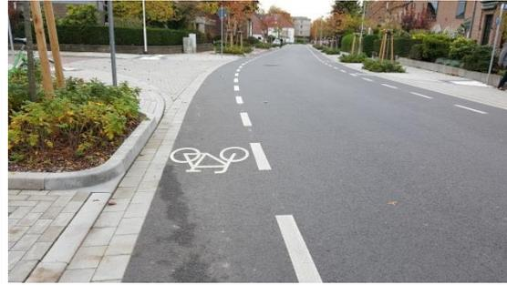
Abb. 4.2.6-5 Radschutzstreifen, GoebelstraÙe
