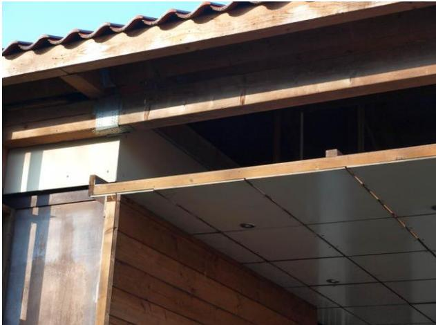
Foto 11: Aufnahme Dachbereich (Eingangsbereich Wohngebäude –Nierenberger Str. 136) mit Vielzahl an Spalten und Öffnungen an Holzverschalungen
