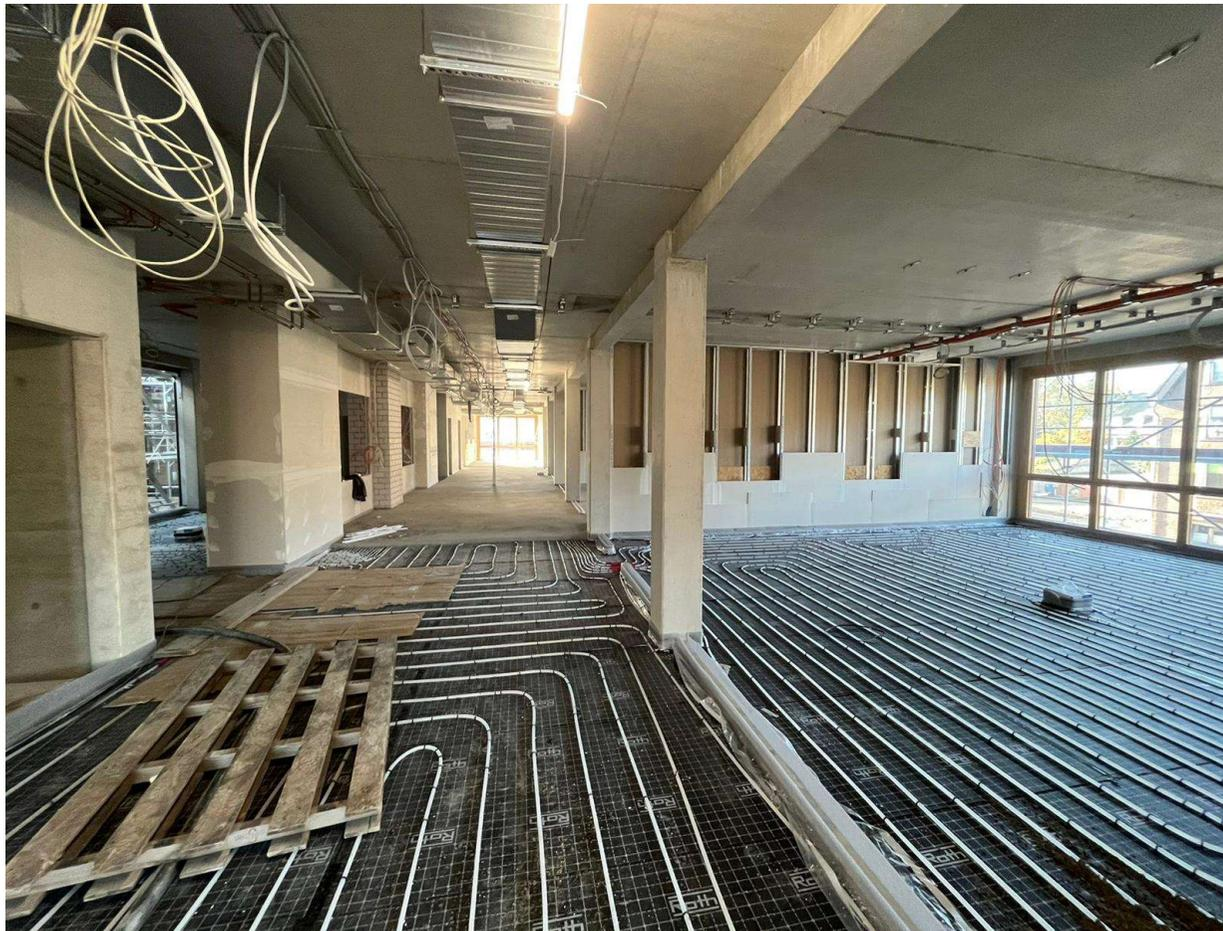
Fußbodenheizung vor dem Einbringen des Estrich ist im kompletten Gebäude abgeschlossen
