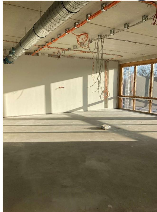
Fußboden nach Einbringung Estrich aktueller Stand in allen Räumen
