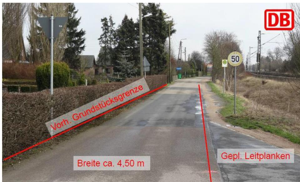
Der Bahnweg weist, wie in den Abbildungen ersichtlich, eine Breite lediglich von 4,50 m auf. Dadurch wird Begegnungsverkehr LKW/PKW unmöglich. Am Bahnweg ist eine Spedition ansässig (Bahnweg 150), somit wird es regelmäßig zu dem Begegnungsfall zwischen LKW und PKW kommen. Des Weiteren wird die Strecke durch den ÖPNV befahren. Dieser ist ebenfalls auf entsprechende Straßenbreiten angewiesen. Eine Verbreiterung ist stellenweise nicht möglich, da sich vor Ort ein Friedhof befindet.
