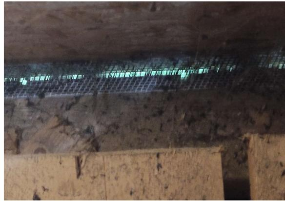
Bild 6: Mit feinem Lochblech durchgängig versperrter Zwischenraum (eigene Aufnahme 02.06.2023)
